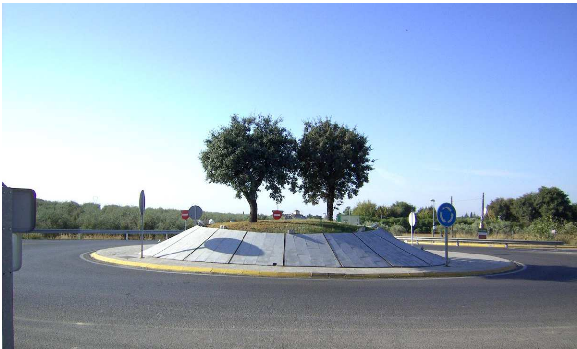
Imagen: Rotonda. Foto: Plataforma Valencina Habitable
