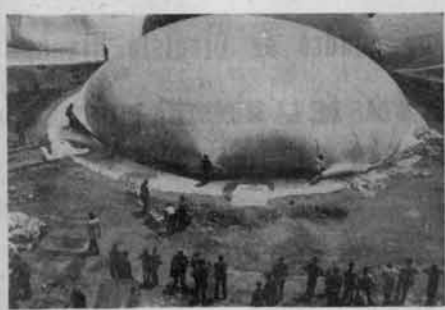
El agua que cubrió paró sobre las cúpulas retrató el inflado y fue preciso ayudar manualmente, como muestra la foto. — (Foto ZUBETA).
